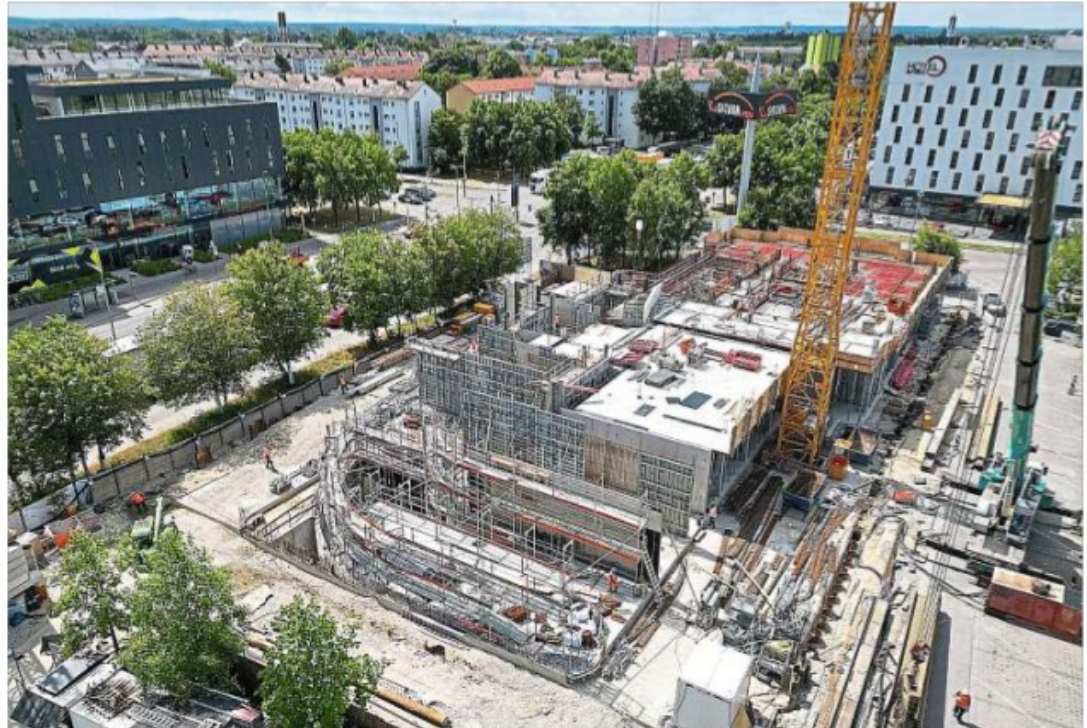
Der aktuelle Baufortschritt am Donau-Tower.
